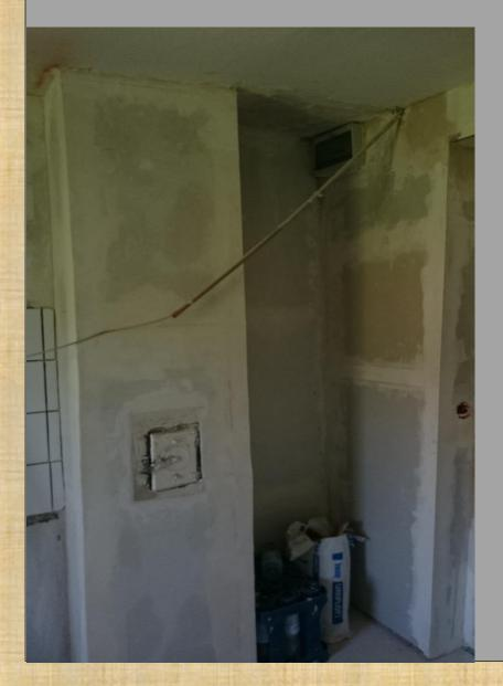
Gipsplatten wurden an die Wände angebracht und somit verkleidet.
